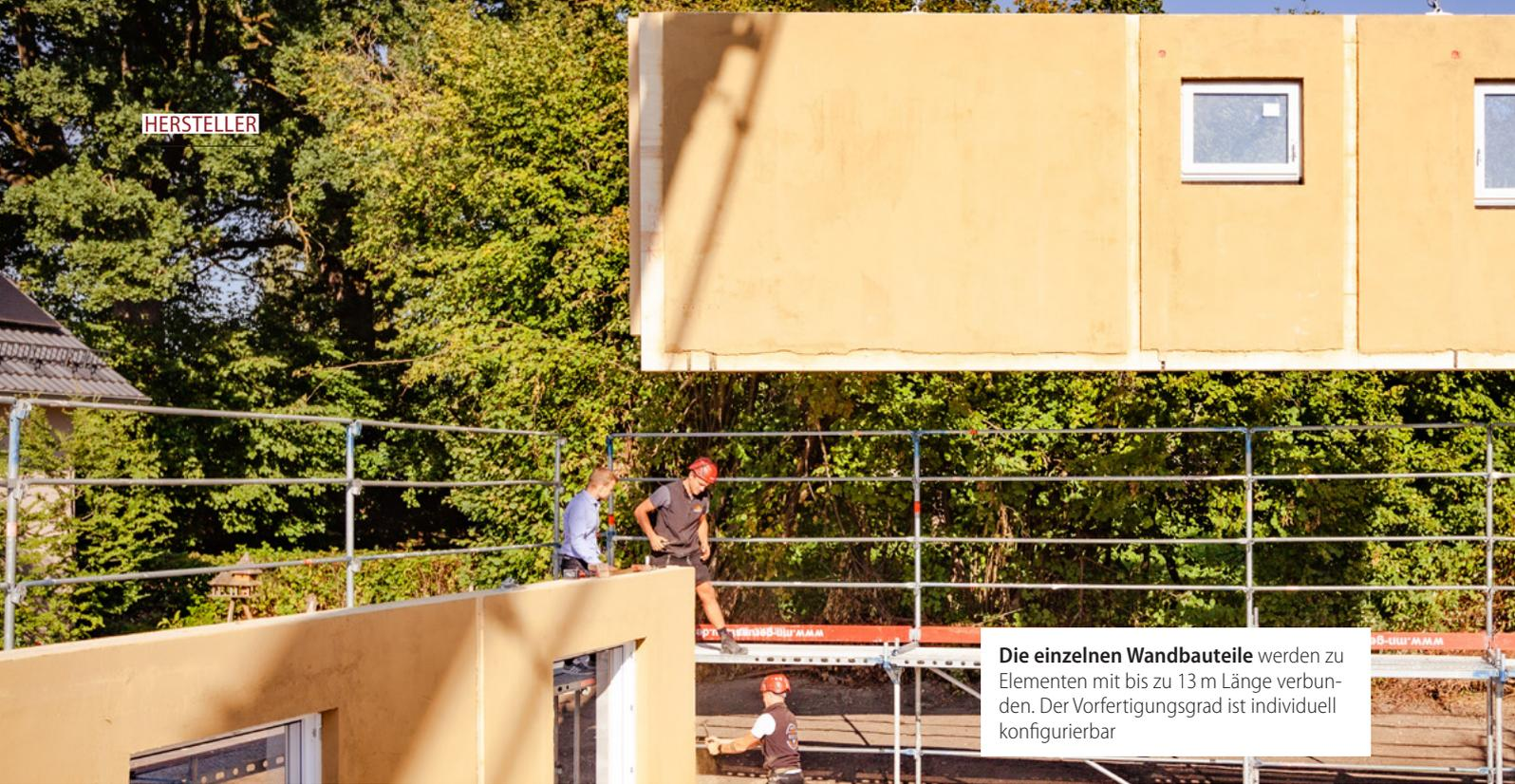
Die einzelnen Wandbauteile werden zu Elementen mit bis zu 13 m Länge verbunden. Der Vorfertigungsgrad ist individuell konfigurierbar
